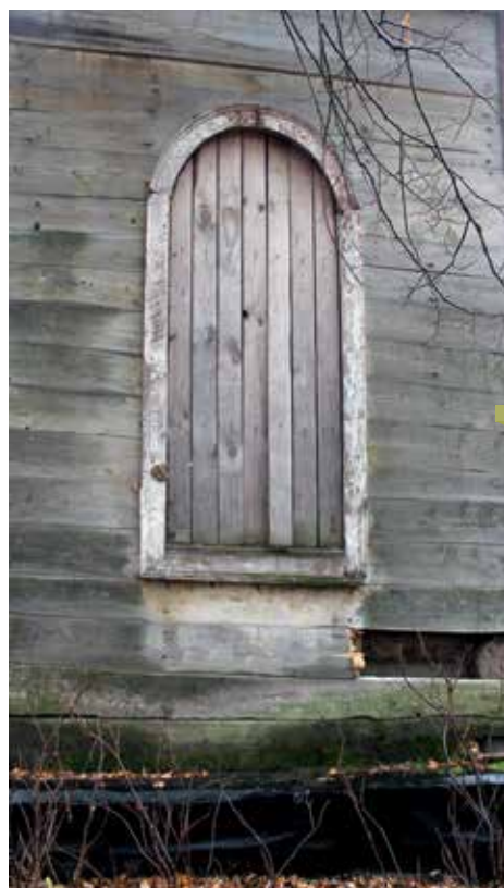
Илл. 3. Деревянному усадебному дому Васино более двух веков, но разрушительное действие времени коснулось только навесного фасада, под ним реставраторы увидели крепкий сруб.
