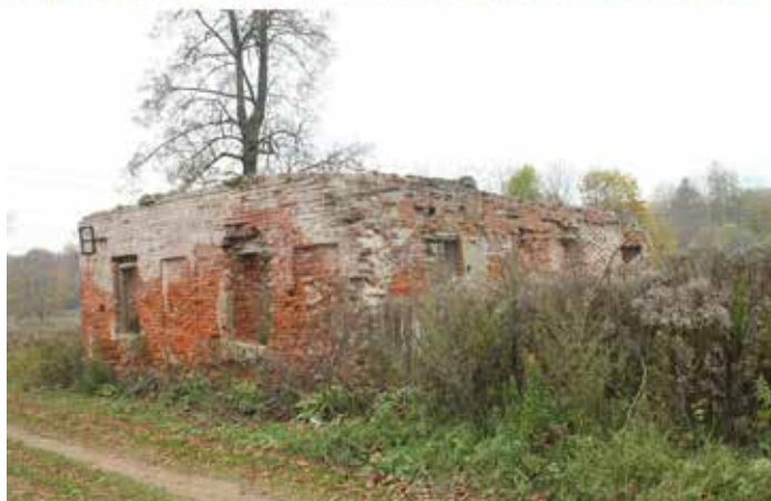
Илл. 20. Служебная постройка. Фотография 2015 года
