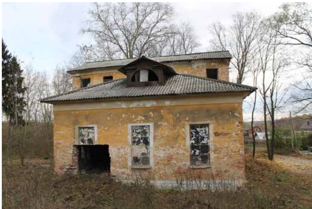
Илл. 23. Западный фасад главного дома. Фотография 2015 года
