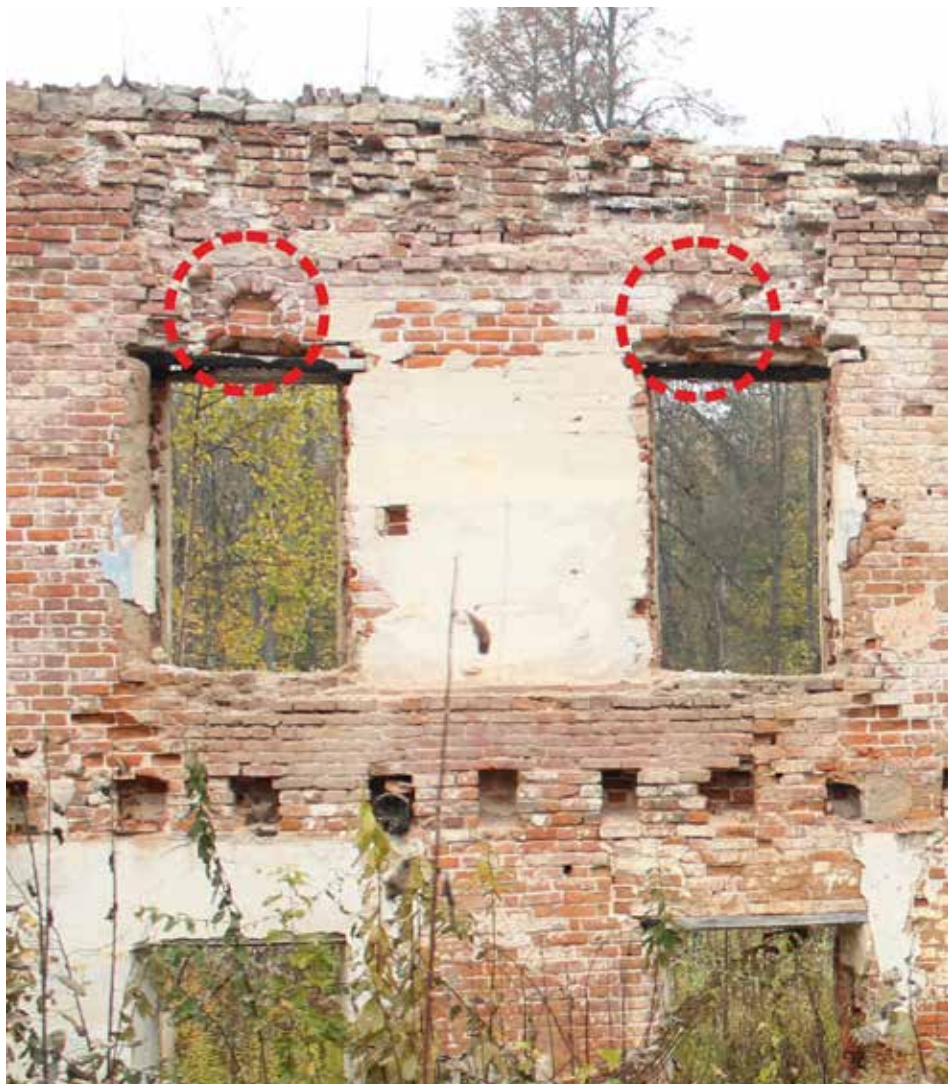
Илл. 7. Обнаруженные ниши на внутренней стене флигеля. Фотография 2015 года
