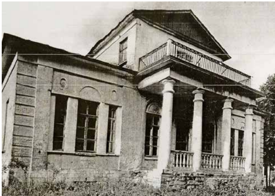
Илл. 19. Южный фасад главного дома. Фотография 1970 года. Архив государственного музея имени А.В.Щусева
