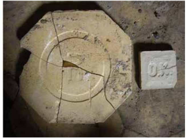
Ил. 2. Метлахская керамическая плитка на лестничной клетке. Зондажное раскрытие западного фасада
