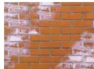
Ил. 8. Пример химической защиты стен – гидрофобизация участка стены специальными растворами. Фото с сайта http://www.termoplex.ru
