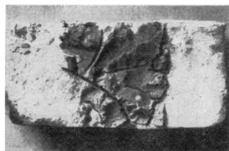
Ил. 5. Усадочные трещины в цементном растворе на сухом кирпиче. Зворыкин Н. «Растворы для инъекций каменной кладки»
