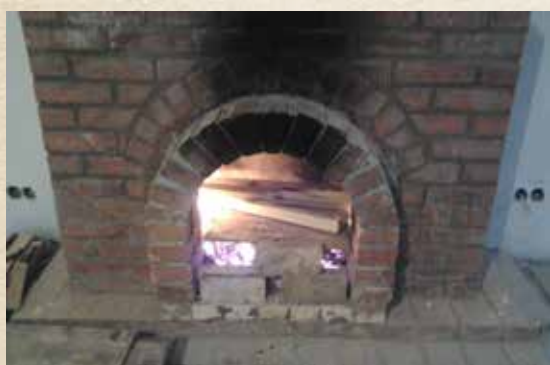
Ил. 5. Восстановление разрушенной кладки дымохода камина и топливника в усадьбе Талицы
