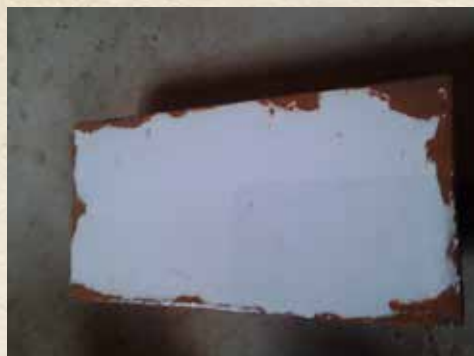
Ил. 8. Удаление неоднородных слоев смывками и ручным инструментом; покрытие очищенных элементов закрепляющим составом; работа с растворными составами по докомпоновке утраченных элементов; покрытие поверхности докомпонованных либо вновь изготовленных поверхностей терракотовым составом
