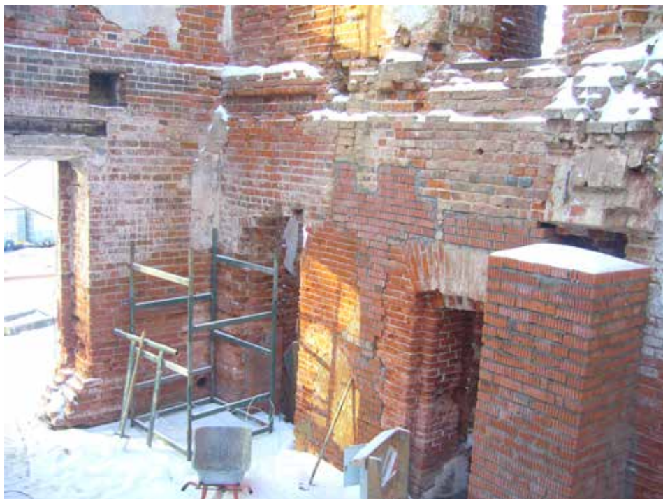
Ил. 3. Вычинка участка стен главного дома усадьбы Тарасково в ходе реставрационных работ ASG
