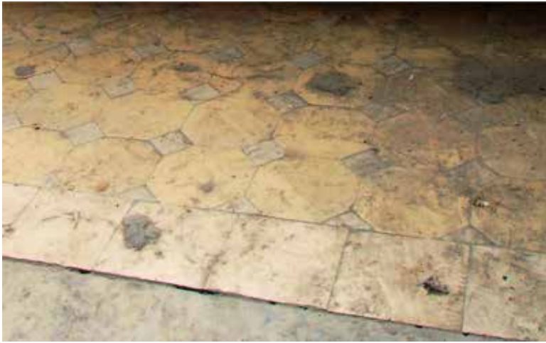
Ил. 2. Метлахская керамическая плитка на лестничной клетке. Зондажное раскрытие западного фасада
