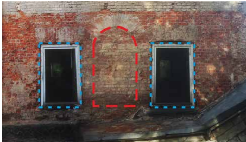
Ил. 3. Фиксация разновременных прямоугольных и арочных проёмов
