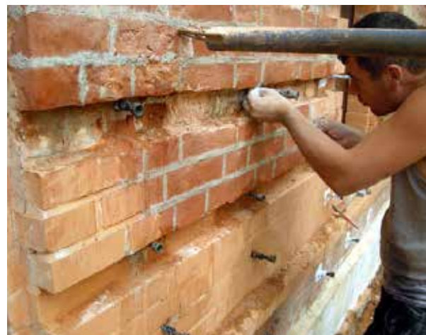
Ил. 6. Вычинку закрепляют к стене инъектированием с армированием стеклопластиковыми анкерами периодического профиля. Фото из отчета по реставрации Братского корпуса Борисоглебского монастыря в Торжке
