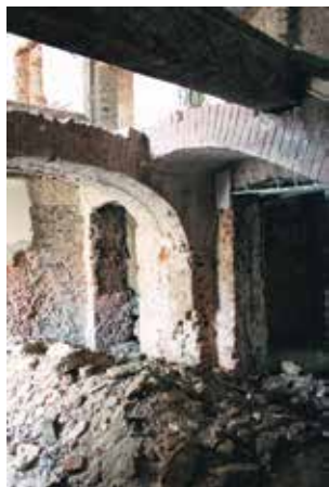
Илл. 1. Сохранившиеся сводчатые перекрытия на первом этаже
