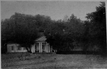
Домъ Н. В. Гоголя въ Васильевскѣ (разрушенъ).
